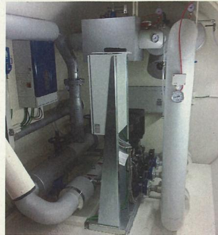
NELLA STAZIONE DI POMPAGGIO: si tratta di una struttura preassemblata che ospita i dispositivi di filtrazione, contabilizzazione e pompaggio dell'acqua, dotata di soccorso anti-allagamento e anticondensa.
