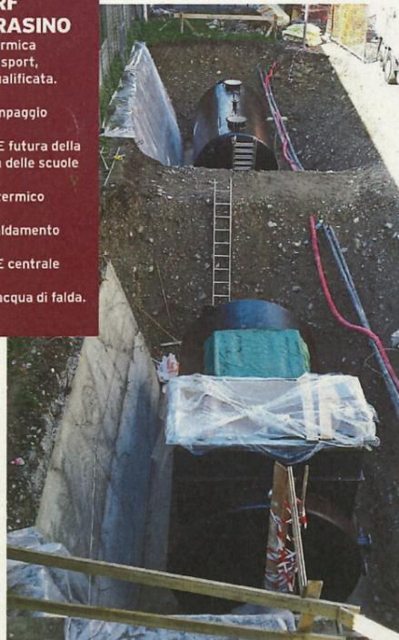
VISTA DEGLI SCAVI per la posa in opera della stazione di pompaggio (in primo piano) e del serbatoio geotermico termostato: l'intero impianto TLRf risulta esterno rispetto all'impronta a terra degli edifici.
