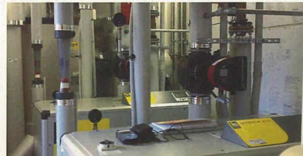
LA CENTRALE TERMICA del palazzetto dello sport rinnovata: l'impianto TLRf si presta alla riquilibratura delle centrali termiche degli edifici pubblici e privati, senza la necessità di interventi sugli impianti a valle delle centrali.
