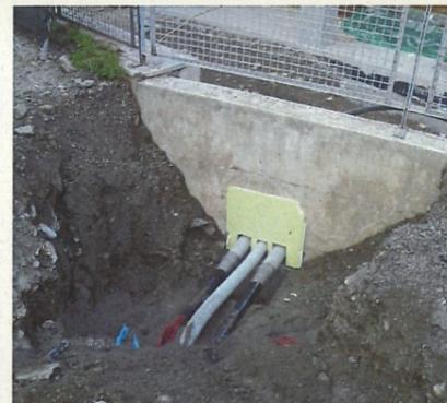
UNO DEGLI STACCHI D'UTENZA che riforniscono le centrali termiche degli edifici: le tubazioni sono realizzate in polietilene senza isolamento, per agevolare lo scambio termico con il terreno.
